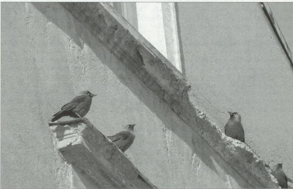
Abb. 45. Dohlen an einem maroden Gebäude in Blockrandbebauung im Stadtteil Altchemnitz. Die Sanierung derartiger Bauwerke schränkt das Nistplatzangebot für Dohlen zunehmend ein. - Foto: J. BÖRNER (Februar 2006).
