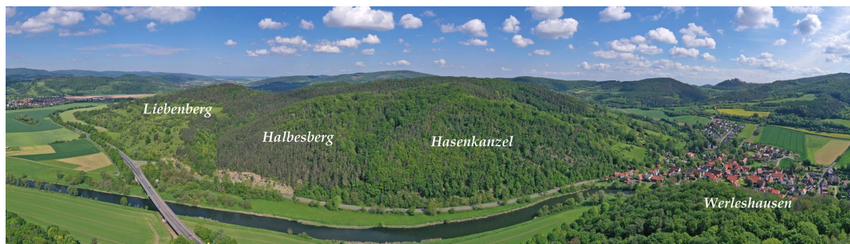
Abb. 3: Der Muschelkalk am Halbesberg und Liebenberg ist durch ein Kerbtal vom Buntsandstein der Hasenkanzel getrennt. Bei Hochwasser reicht das Wasser der Werra bis an den Straßendamm der L3469.
