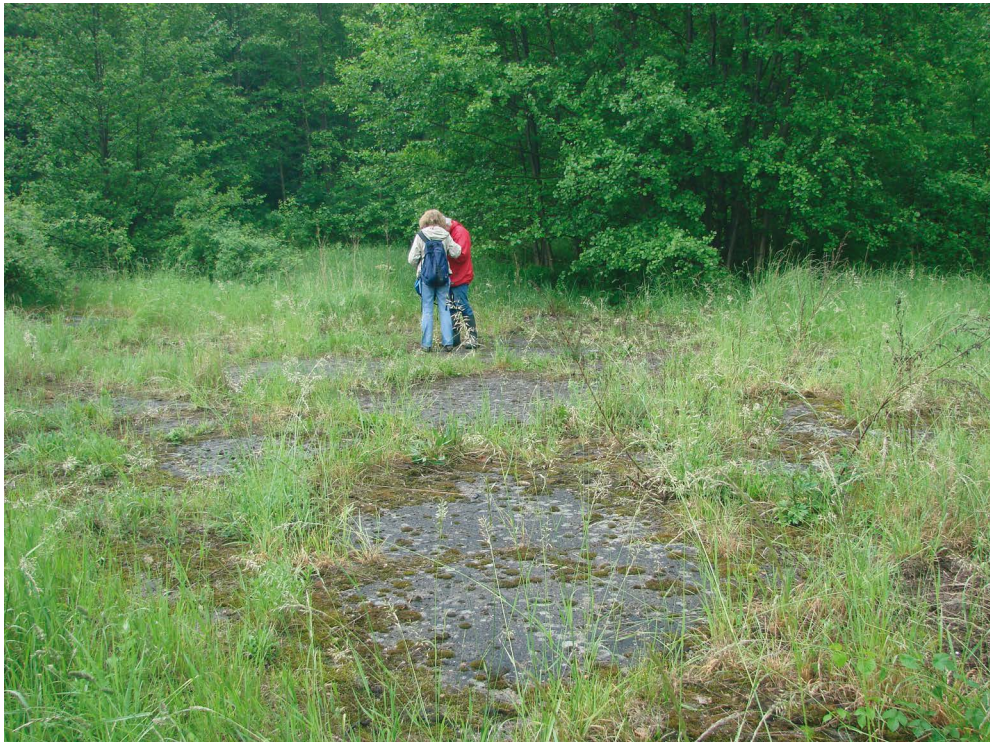
Abb. 2: Falkenberg/Mark, ehemalige Papierfabrik: Betonfläche an der ehemaligen Wassermühle (Foto: I. RICHLING, 31.5.2013)
