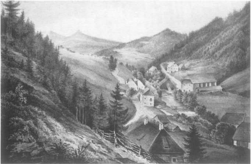
Das Werksgelände des ehemaligen Zeilingerhammers in Rettenegg bei Birkfeld
