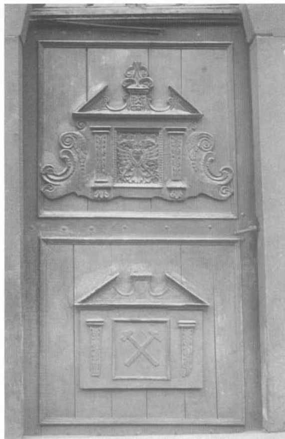
Detailsicht der Eingangstüre des Wohnhauses Schladming Nr. 68
