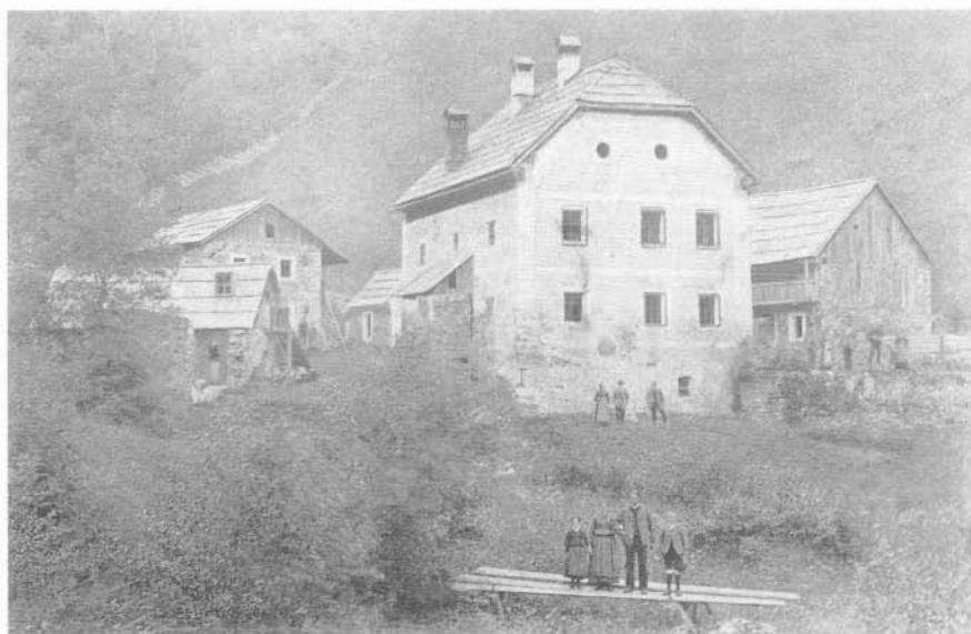
Das ehemalige Sensenhammerwerk in Pruggern
