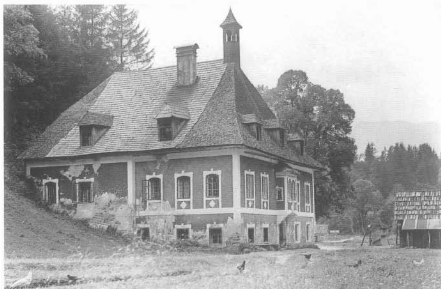
Ehemaliges Hammerherrenhaus in der Gulling bei Aigen im Ennstal
