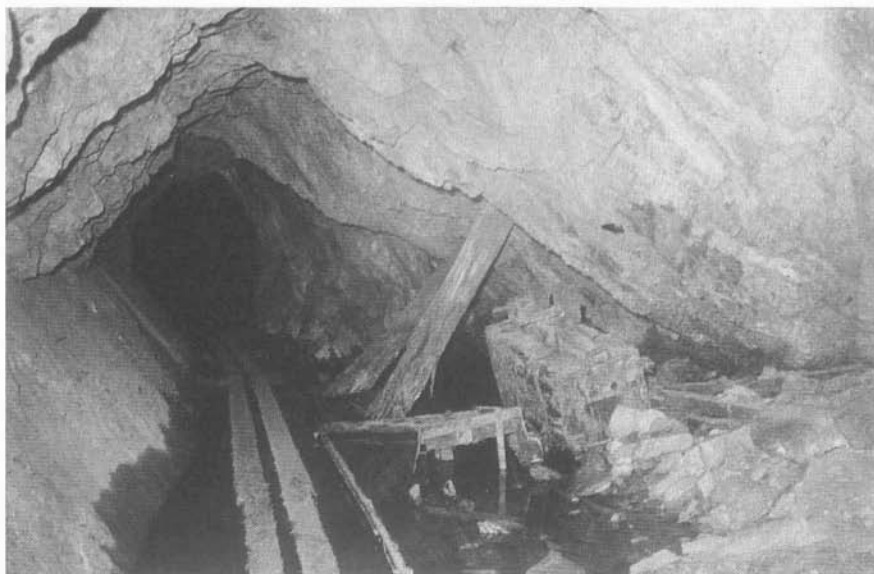
Ersoffene Strecke in der Zinkwand im Schladminger Obertal
