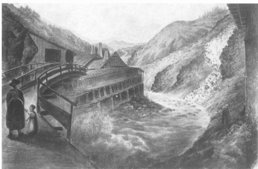
Werksanlagen in der „langen Teichen“ bei Kalwang
