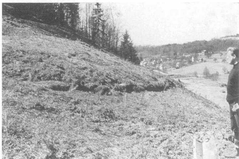
Abb. 24. Südautobahn bei Autal
