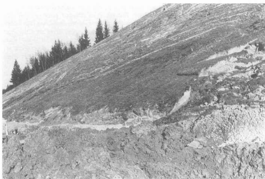
Abb. 23. Südautobahn westlich Gleisdorf
