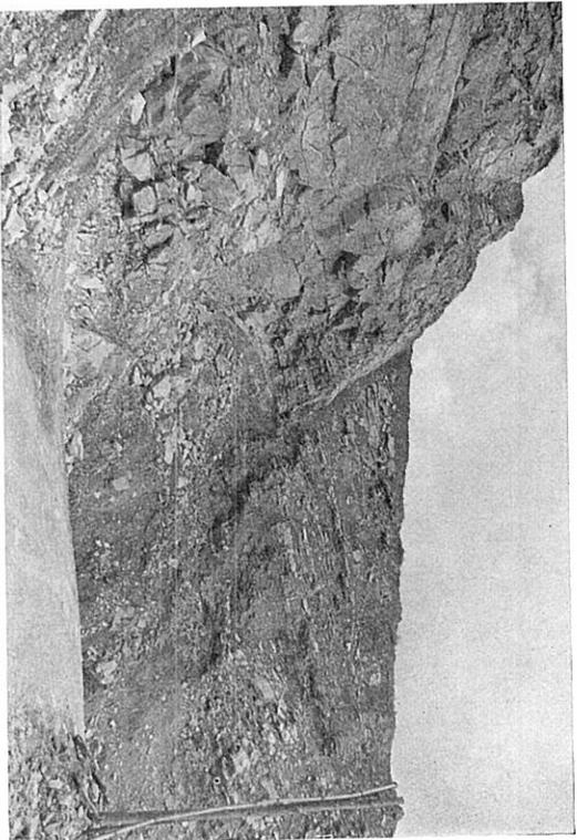
Abb. 16: Rechts die Ostflanke, links der mittlere Teil des Bruches. In der Bildmitte erkennt man eine nach rechts unten verlaufende Störung. Von der Bruchwand sind einzelne Schalen abgesprungen und abgestürzt.
