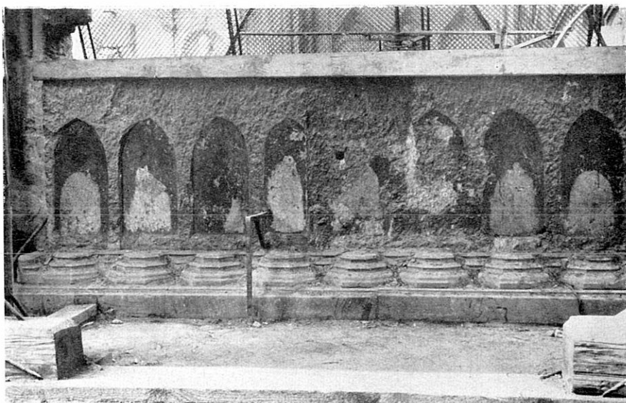
Abb. 14: Block der Rudolfs- tumba nach Entfernung der Blendarkaden Fohnsdorfer Muschelkalk (aus Kieslinger 1949)
