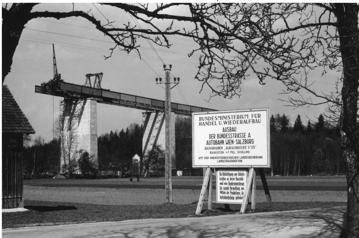
Aufnahme aus den späten 1950er Jahren vom Bau der Westautobahn
