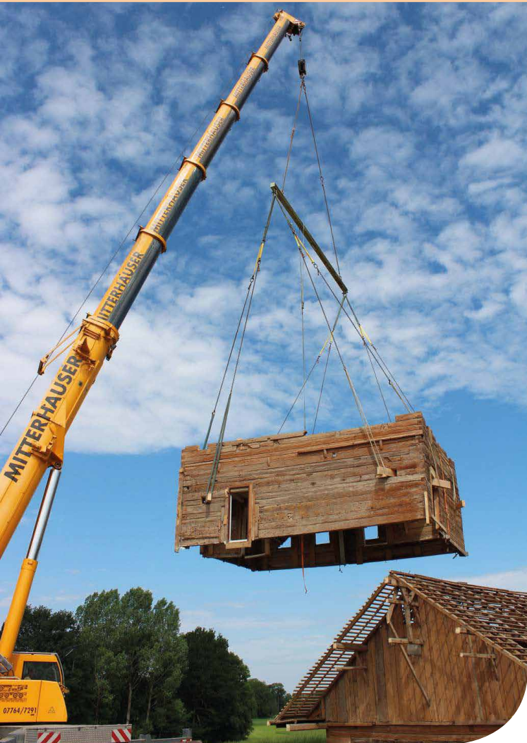
DAS SCHWEBENDE BAUERNSACHERL – UMSETZUNG VIA LASTENKRAN (FOTOS: ANNA WEILHARTNER)
