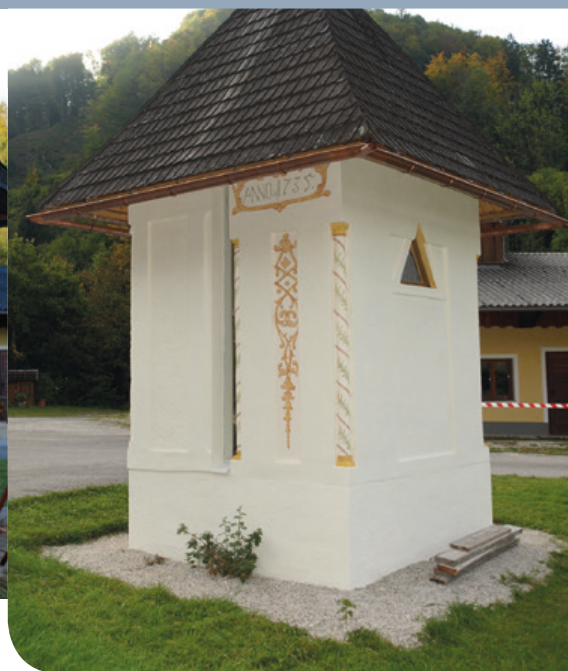
Die rundum sanierte Pulvermacherskapelle mit ihrer durch feine Rankenmalereien gezierten Rieselputzfassade.
