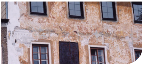
DIE HISTORISCHE SGRAFFITOFASSADE WIRD ZUM VORSCHIEIN GEBRACHT.
