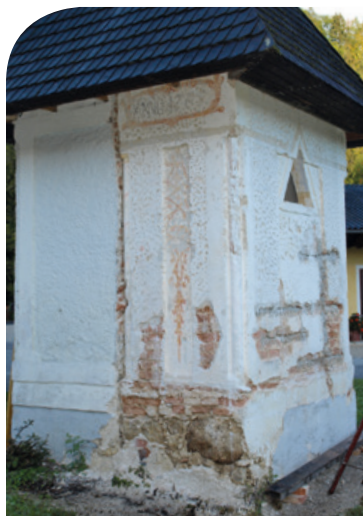
Die Freilegung des Denkmals mit barocken Elementen.
