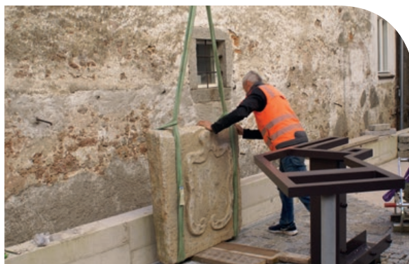
▼ ABB. 7: MONTAGE DES STEINS. | FOTOS: FRITZ WIMMER
