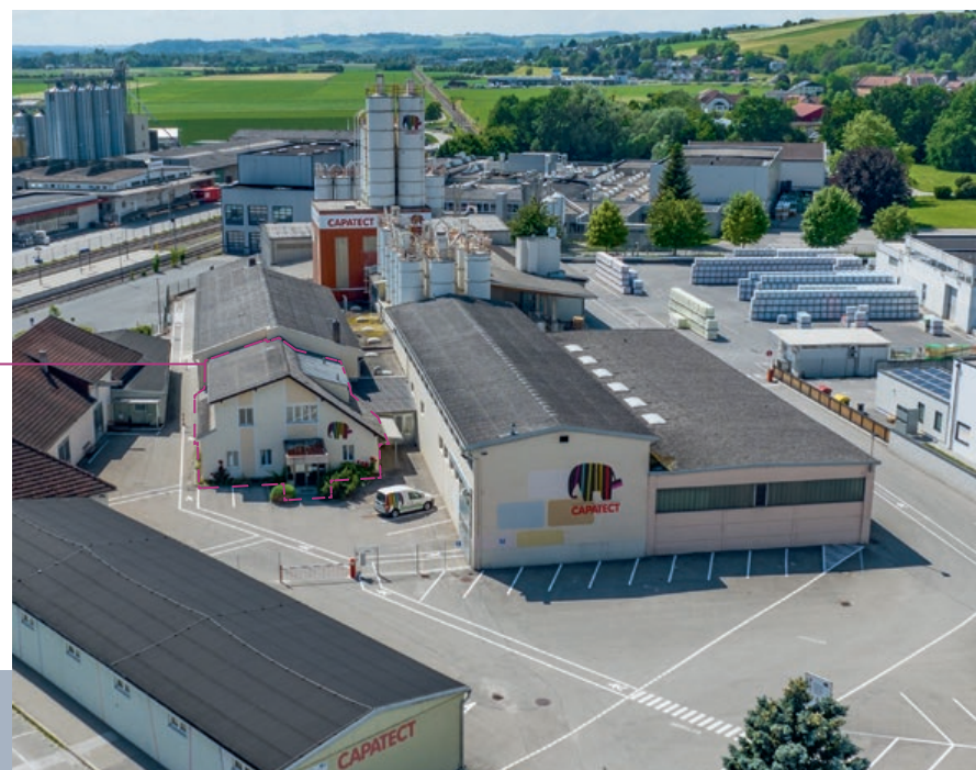
DAS MARKIERTE BÜROGEBÄUDE IST JENES AUS DEM BILD LINKS VON 1911. DAS GEBÄUDE WURDE UMGEFÄHR 1965 LEDIGLICH AUF DER LINKEN SEITE AUFGESTOCKT. DAS ERDGESCHOSS IST NOCH ORIGINAL ERHALTEN, ZUMINDEST WAS DAS MAUERWERK BETRIFFT. FOTO: BORIS MITTERLEHNER
