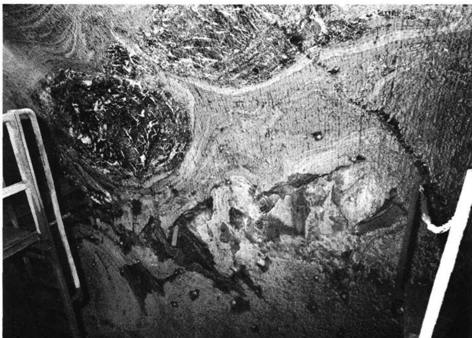
Abb. 7: Anhydrit im Valkastielstollen. Bildhöhe rund 5 m.
