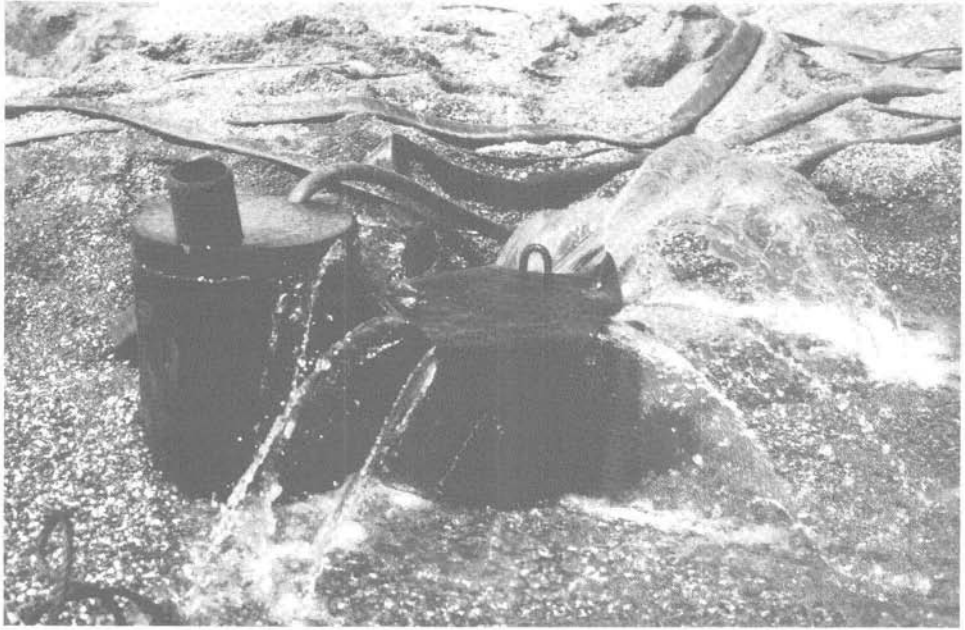
Abb. 5: Gespanntes Grundwasser am Brunnen 3.
