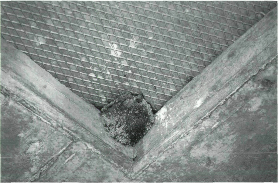
Abb. 1: Mehlschwalbennest an einem Einstiegsdeckel der Steinbergbrücke
