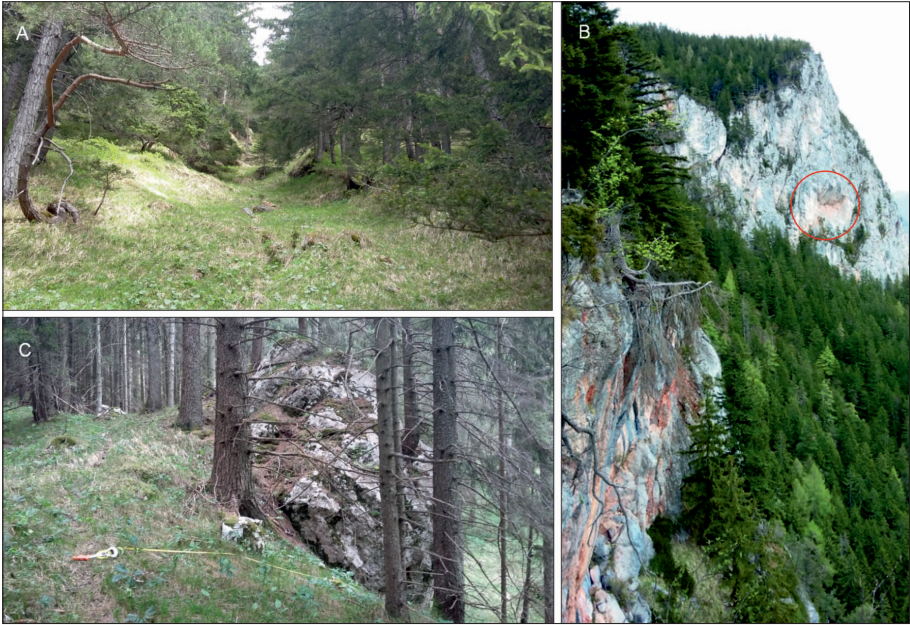
Abb. 4: (A) Relikte Murbahn. (B) Blick vom Rand der Anbruchnische des westlichen Felssturzes zum Ausbruch (roter Kreis) in der Pürgger Wand. (C) Block an der Krone des westlichen levées in 795 m ü. A.
