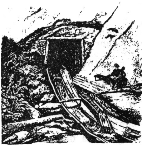
Huebmerscher Durchschlag mit durchgeführter Wasserriese.
