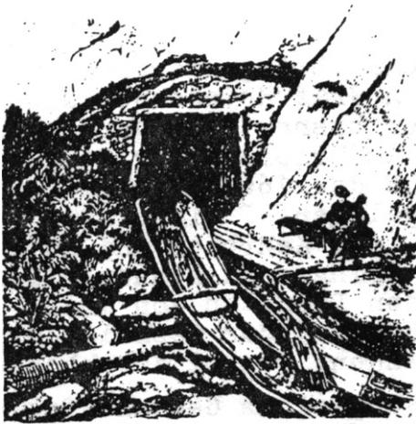
Huebmerscher Durchschlag mit durchgeführter Wasserriese.
