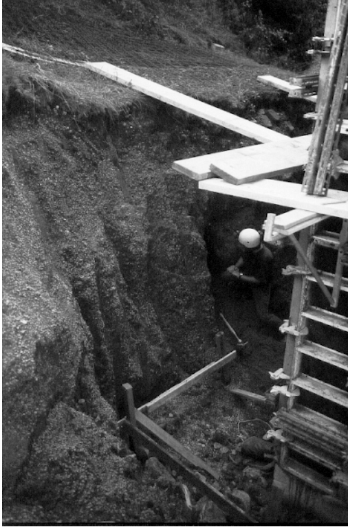
Abb.1: Eingang zum Stollen Mollmannsreith an der Südost-Ecke des Turnsaal-Neubaues der Volksschule - Foto: F. FRITSCH
