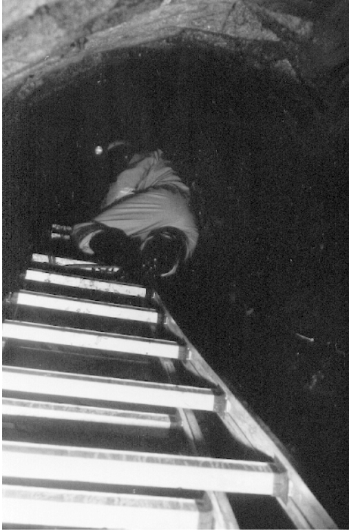
Abb. 9: Abstieg in den Wasserstollen Stadler (Hochetting II) mittels einer 5 m langen Leiter. - Foto: E. FRITSCH
