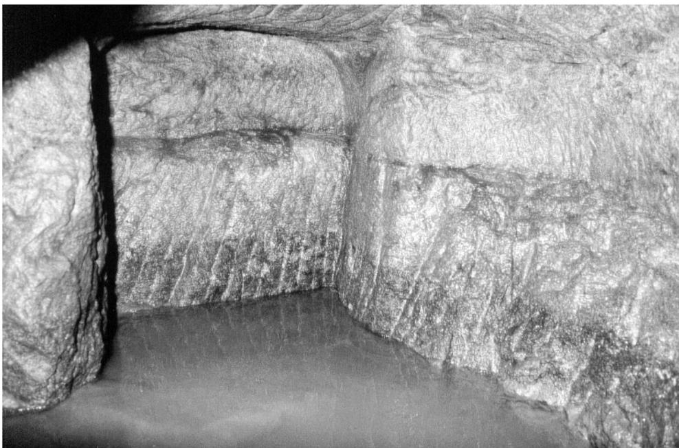
**Abb. 8:** Stollen **Hochetmühle (Hochetting I)**. Felsnische mit Hauspuren am ersten „See“ (Gangknick). – Foto: E. Fritsch
