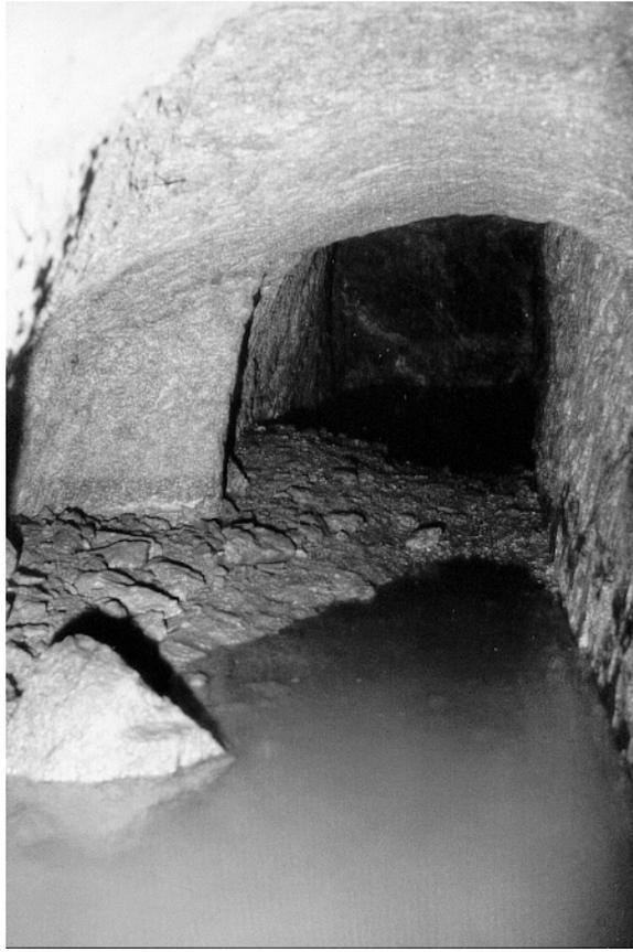
**Abb. 7:** Stollen **Hochetmühle**. Der niedrige Verbindungsgang mit Abraum zwischen erstem „See“ und Endkammer ( „Quelltonf“ ) - Foto: F. FRITSCH
