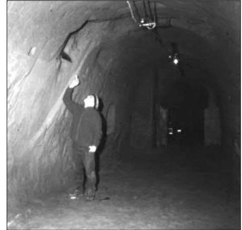
Abb. 19: Im mittleren Teil des Andorfer Feichtnerkellers beim 1985 gebohrten Lüftungsschacht. – Foto: E. FRITSCH, 2003
