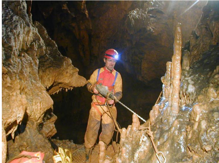
H. Moor beim Einbohren einer Klettersteigverankerung vor dem Schwarzen Loch
