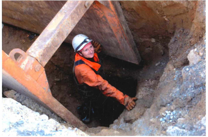
Einstieg in den Erdstall am nordwestlichen Ende der Künette (Kanal-Baustelle, 9.8.2014)
