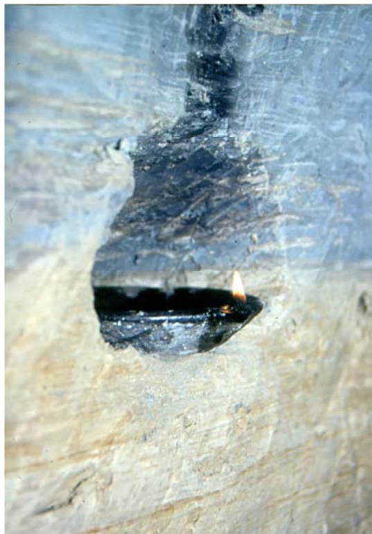
Der Hauer schlug beim Vortrieb einfach eine kleine Nische in die Wand und stellte hier seine Lampe ab. Lampennische mit Tonlampe im Versuchs-Erdstall in Tollet. (© J. Weichenberger)
