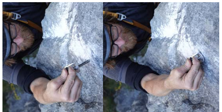
Bild 2: Beim Setzen eines Petzl Pulse-Ankers
