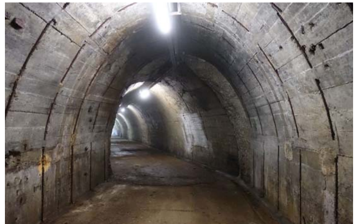
Bild 2: Verbindungsstollen in der Anlage "Schlier"
