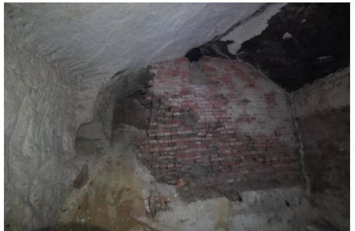
Absicherung nach einem Bombentreffer
