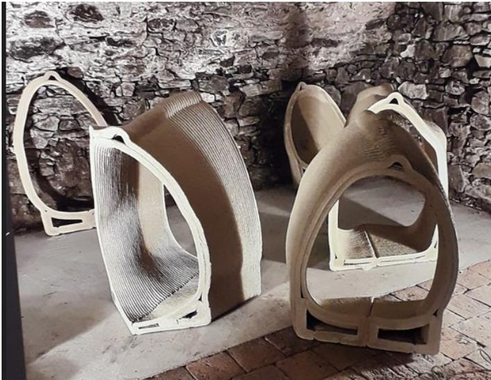
**Bild 8: Mittels Betondrucker wurde ein Erdstallgang in Teilen produziert, dann in den Keller transportiert, dort zusammengefügt.**
