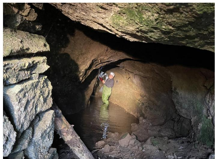
Bild 21: Der große Deckstein und eine kurze Mauer leiten in den Wassergang über.
