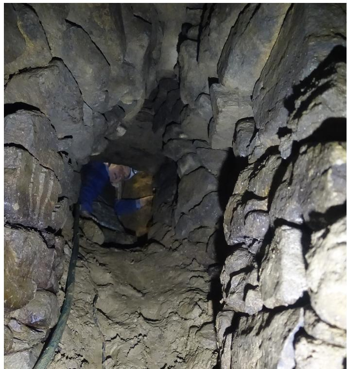
**Bild 15:** Erdstall Reinolz – Der erste Abschnitt ist durch ein Kraggewölbe (falschem Gewölbe) gebildet.
