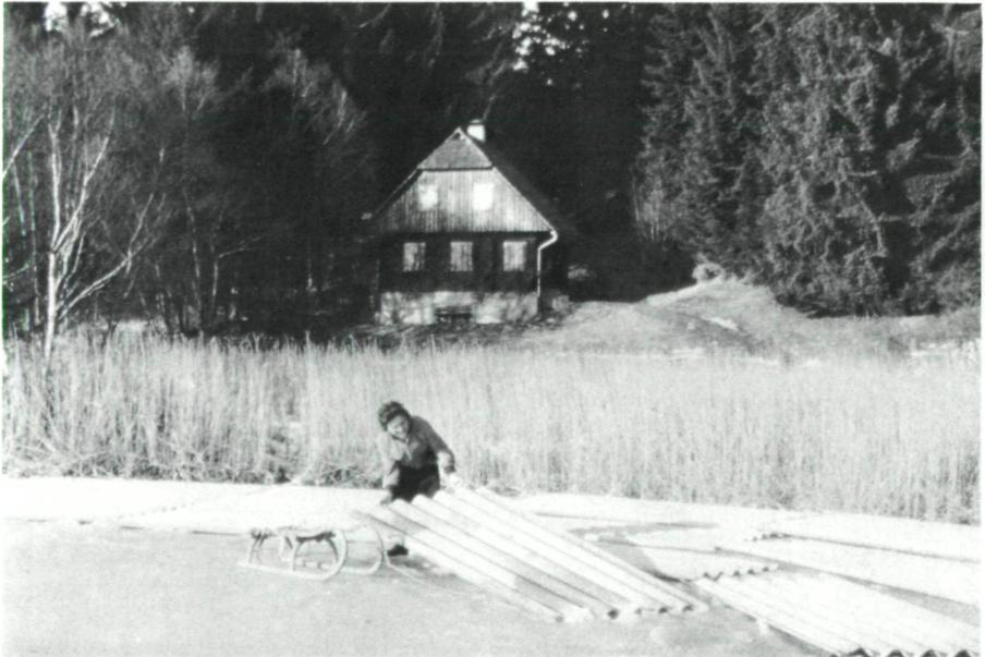
Abb. 1.: Verlegen der Eternitplatten auf dem Eis des neugeschaffenen Seichtwassers (Foto: E. HABLE).
