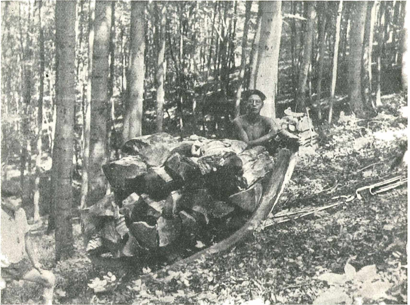
Abb. 11: Aufseilen von Schichtholz im Steilhange mit 30 cm Geschwindigkeit. Ansicht von rechts.
