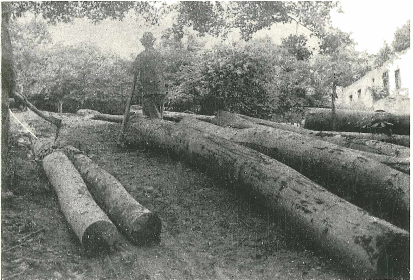
Abb. 8: Aufseilen von zwei Buchenschwellenblochen zugleich und nebeneinander mit 60 cm Geschwindigkeit. Ganz links auf dem Bilde der Standpunkt der Maschine an der Straße.
