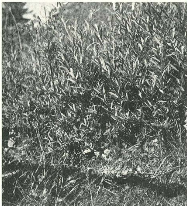
Abb. 125: Eine „Weidenbuschlage auf Reisigunterlage“ nach V. Praxl im Gallinabach; vorne Heublumensaat.
