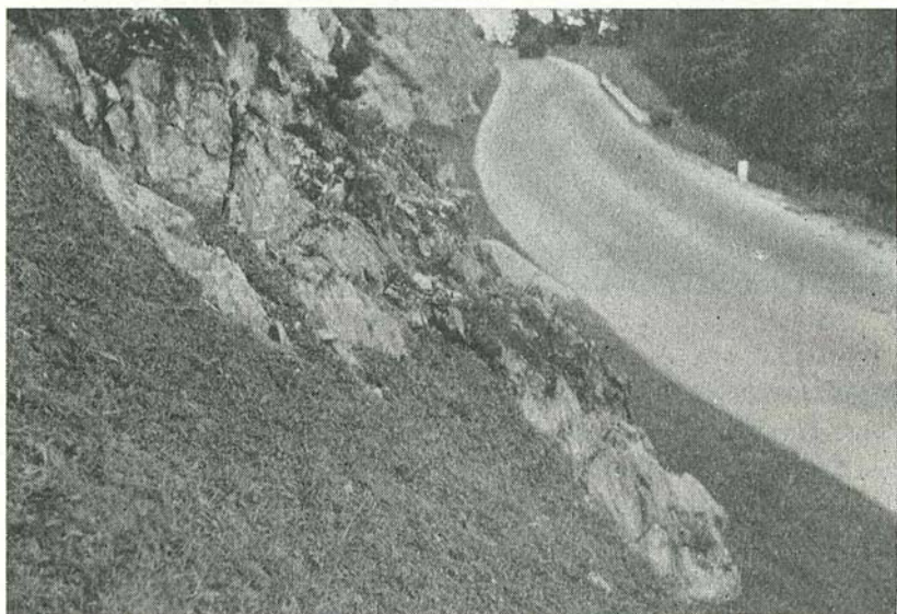
Abb. 151: Begrünung mit Rasenziegeln am Steilhang (vorne) und Saat am flachen Straßenrand. Neue Achenseestraße.
