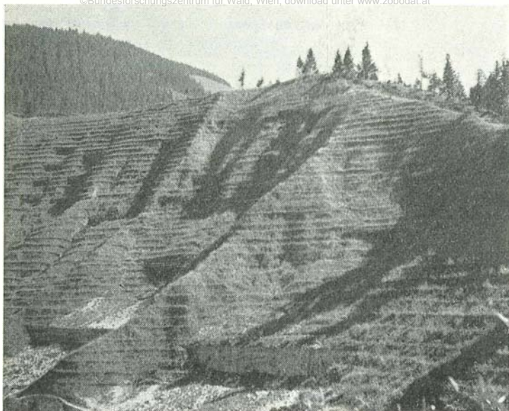
Abb. 124: Teil des fertig begrüntem Filpittertobels im Gallinabach bei Feldkirch. Grünverbauung 1–3 Jahre alt.
