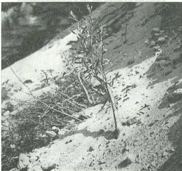
Abb. 121: Winderodierte Weidenbuschlage.
