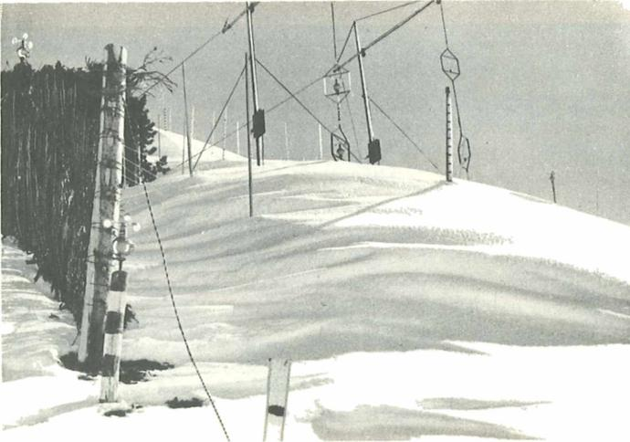
Abb. 159: Ablagerung hinter Schneezaunen aus Zirben- und Wacholderästen (Höhe 1,8 m, Füllung 50 %)
