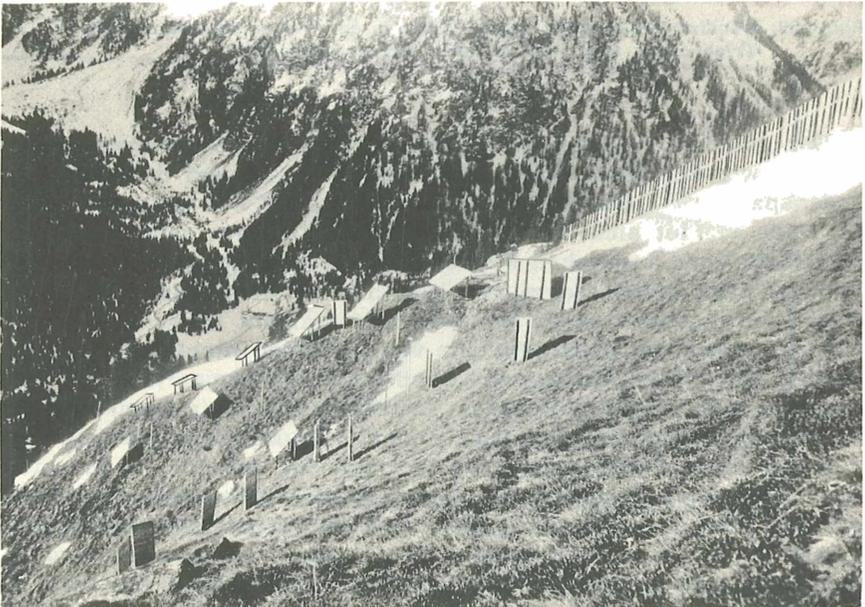
**Abb. 171:** Beispiel der Windverbauung einer Lawine (Versuchsgelände Paida 1900 m) mit Kolktafeln (oberstes Abbruchgebiet), Düsen und Kolktafeln (Wächtenrand) und Schneezaun (flaches Vorgelände)
