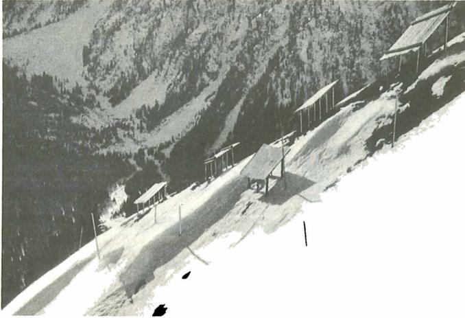
**Abb. 169: Wächtenverhinderung durch Düsen in der Versuchsverbauung Paida. Der Triebsschnee wird weit in den Leehang verfrachtet**
