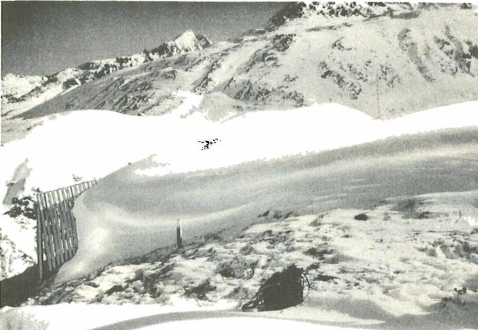
Abb. 164: Gesättigte Ablagerung im Bereiche eines Schneezaunes (Höhe 2 m, Füllung 80 %) auf der "Daunmoräne" bei Obergurgl (2.230 m) nach starker Aufleitung des Hangaufwindes
