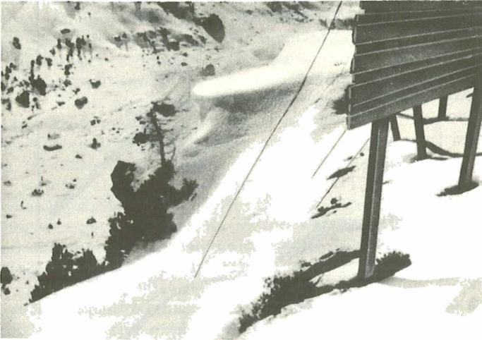
Abb. 167: Kolktafel mit Bodenspalt zur Verhinderung der Wächtenbildung an einem Plateaurand (Versuchsgelände Wattener Lizum)
