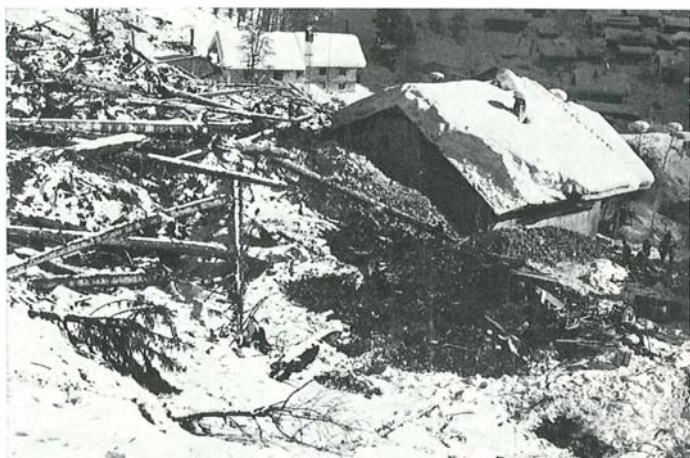
Ansiedlung Motta der Vorarlberger Illwerke, wo 1 Doppelwohnhaus zerstört und 4 andere stark beschädigt wurden. Bei einer weniger massiven Bauweise der Wohnobjekte wäre wahrscheinlich der Großteil der Siedlung, welche während des Lawinenabganges evakuiert war, zerstört worden.
