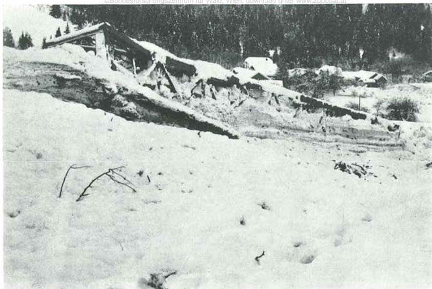
Von der Lawine abgetragene Bahnbrücke.
