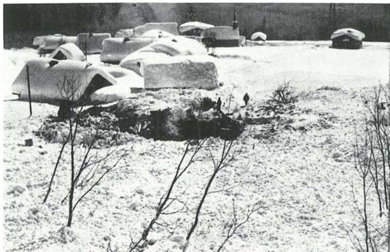
Zerstörtes Wohnobjekt und Stall. Das über 200 Jahre alte Wohnhaus, welches an den Hang gebaut war, fing nach der Zerstörung durch die Lawine Feuer und brannte total aus.
