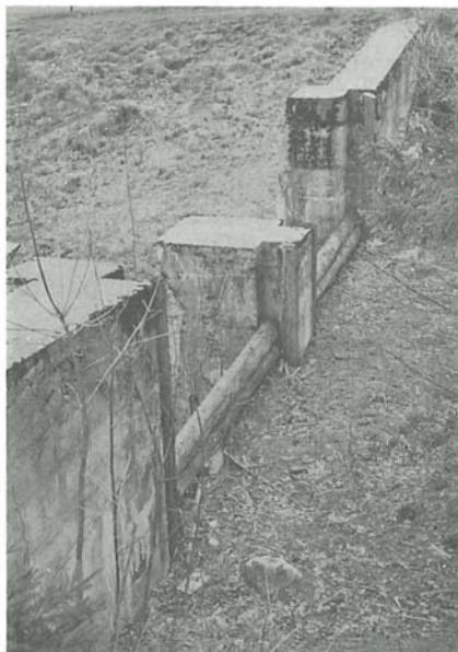
Abb. 5: Balkensperre mit auswechselbaren Holzbalken und Stahlbetonpfeilern im Keerbach in Niederösterreich, nach der sog. Tauschwandbauweise (ZARBOCH bei STRELE 1950) aus dem Jahre 1936, mit talseitiger (oben) und bergseitiger Ansicht (unten) Aufn. Dipl.Ing. Ruf
