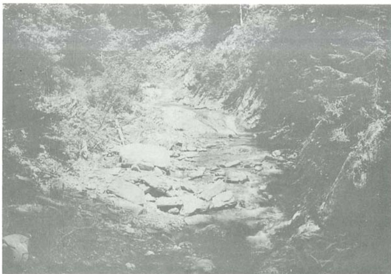
Abb. 16: Sperrenstelle im Kirchbachgraben vor dem Baubeginn bachaufwärts gesehen Aufn. Dipl. Ing. Noisternig
