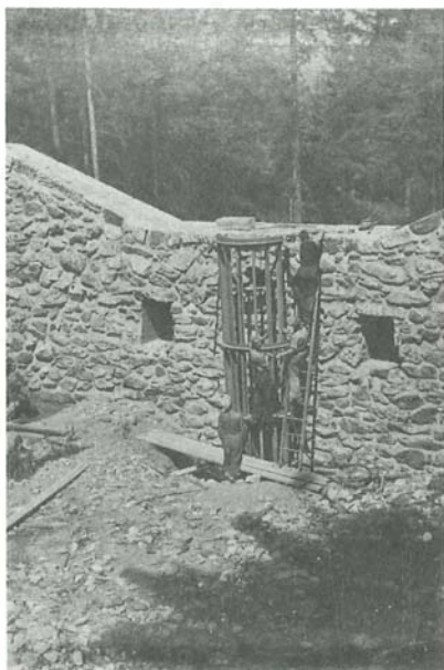
Abb. 2: Montage des Geschiebekorbes im Lünitzbach (Abb. 1)
