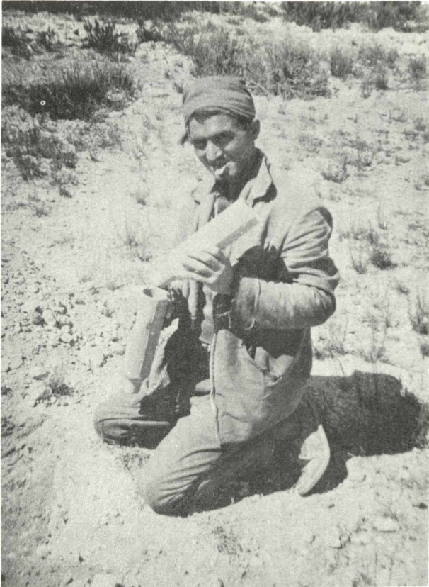
Ouled M'Hamed. Tiefenbewässerungsversuch Zusammenstecken zweier Drainage Röhren
