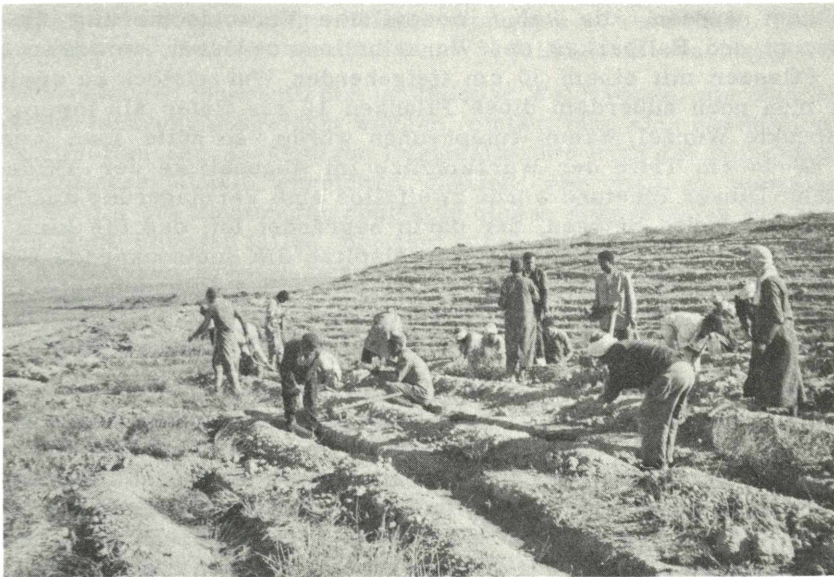
Ouseltia, 1F_1 , Anlage von "unterbrochenen" Pflanzgräben in Schichtenlinien für Pinus halepensis Aufforstung
