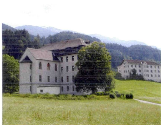
6 Ansitz Hautzenheim in Kleinvolderberg, Ost- und Mittelhaus.
