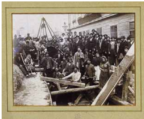
Anlegung der Wiener Gasleitung, 1897 Gebrüder Nedomansky, Fotos
