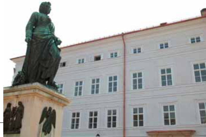
Nord-Fassade mit Mozartdenkmal
