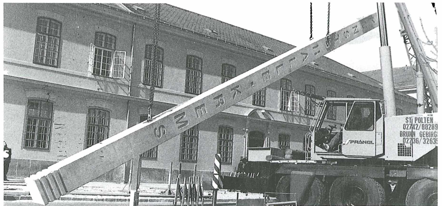
Zur Eröffnung wurde eine 20 Meter hohe Betonstele aufgestellt.
