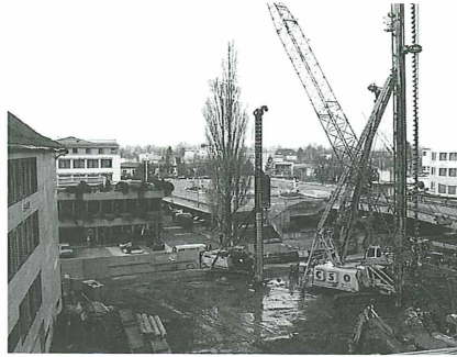
Blick in die gegenüberliegende Tiefbaustelle mit der sich für die Museumsbauten verbeerbend auswirkenden Betonrammpfählung, Frühjahr 1992
