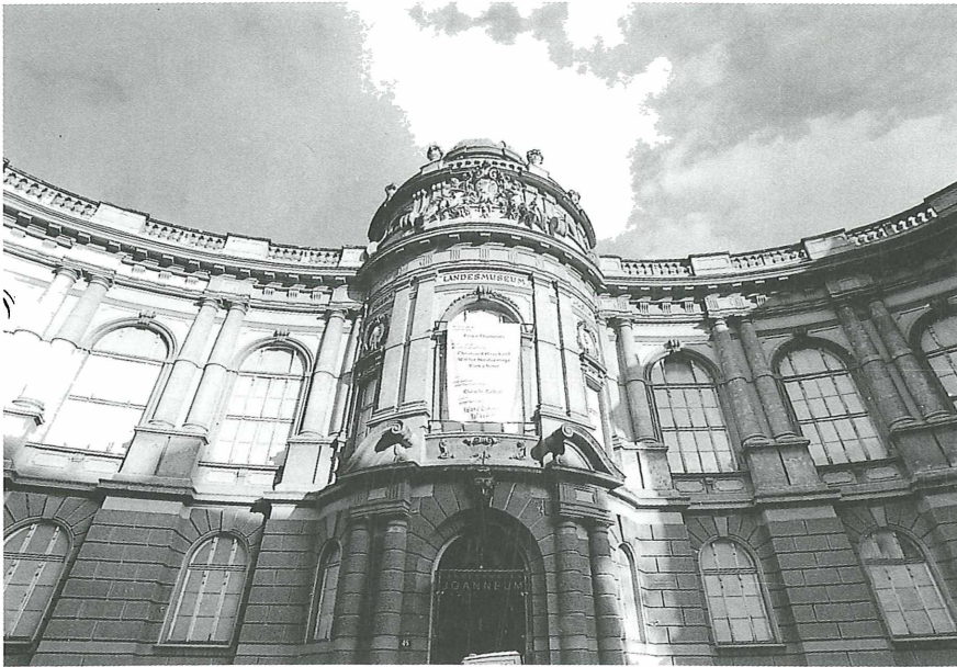
Das Museumsgebäude Neutorgasse wird als Haus der Kunst genutzt werden.
