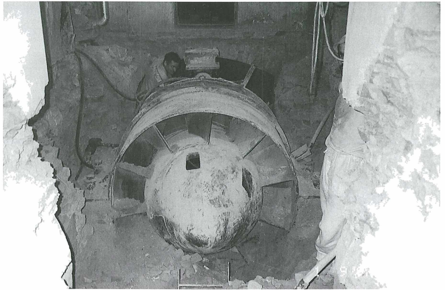
Abbau der Ventilatoren der alten Warmluftheizung
