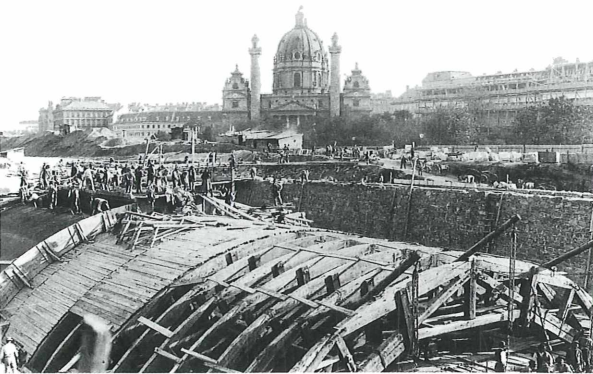
Die Betonierung eines Gewölberinges unterhalb der Elisabethbrücke am 11.10.1898, Albuminpapier
