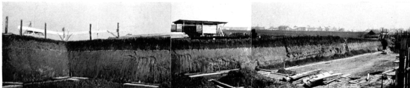
Bild 4: Baugrube der neuen Landwirtschaftlich-chemischen Bundesversuchsanstalt, Pz. 1408/2. Scharfe Trennlinie zwischen hangendem Lehm und liegendem Löß; Auskeilen der Trennlinie gegen Süden zu einer Delle.
