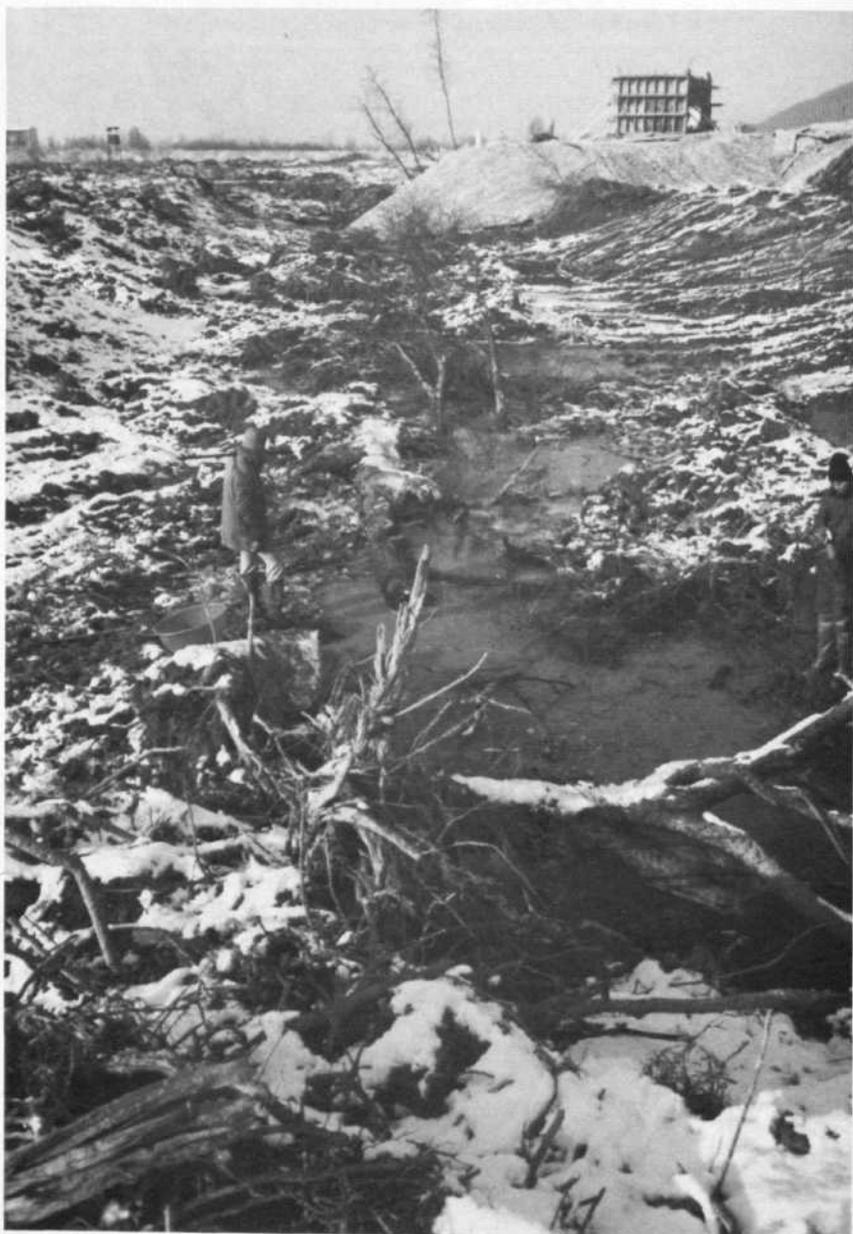
Abb. 3: Ein Altarmrest wird im Bereich des Hauptbauwerkes\* des KW Abwinden zugeschüttet (24. November 1975).
