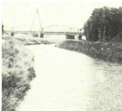
Abb. 7: Umleitungsgraben bei der Steyregger Brücke (Juli 1980)
