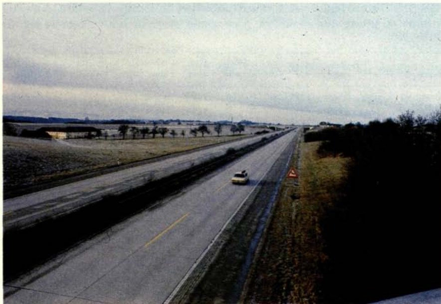
Abb. 10: Beispiel einer breiten Straße (Autobahn) mit Trennwirkung auf den Lebensraum des Rehwildes. / Example of a broad road (motor highway) with extensive dividing effects on roe deer populations.
