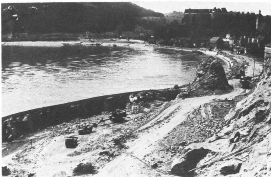
Abb. 12: Bauarbeiten nach der Sprengung (Foto J. Grell).
