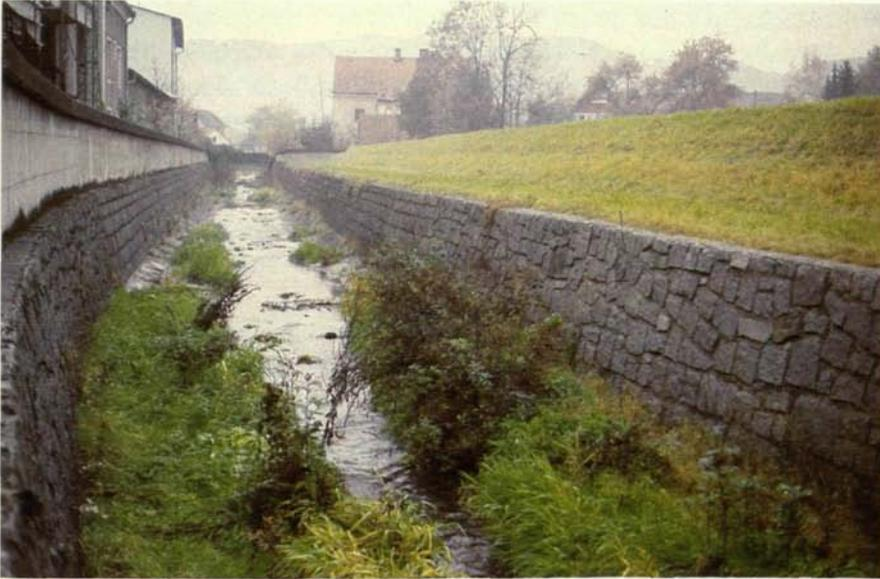
Abb. 13: Ausschnitt aus der Befischungsstrecke 7, einer „harten“ Regulierungsstrecke mit eingeschwemmtem, sandig-erdigem Material und Grasaufwuchs.
