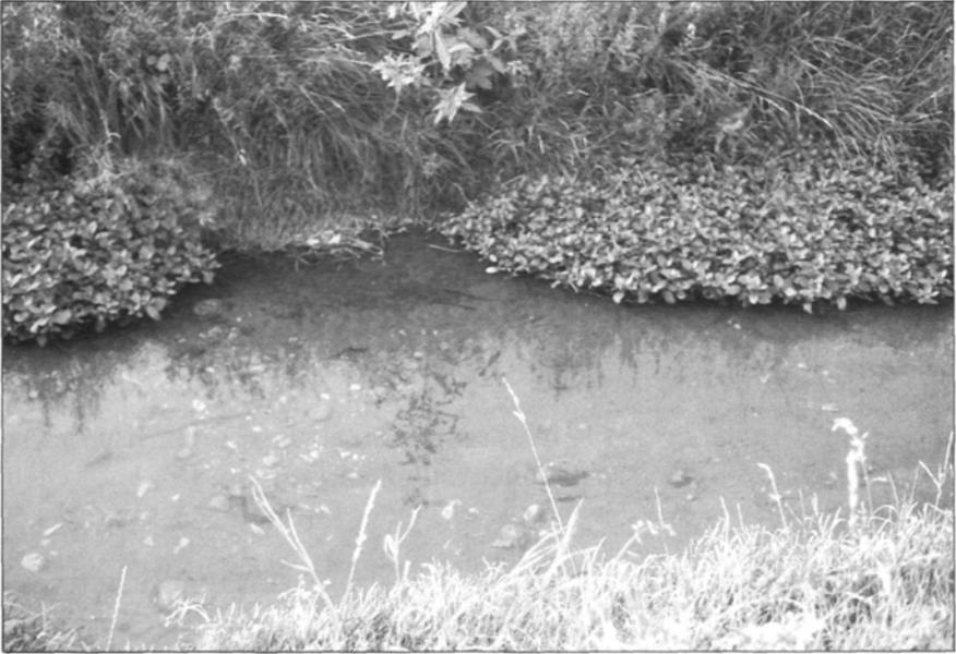
Abb. 6: Sammelgerinne unmittelbar bachabwärts der Höllmühlbacheinmündung – sowohl die befestigte Sohle wie auch der Uferverbau sind in diesem kurz zuvor geräumten Abschnitt zu erkennen.
