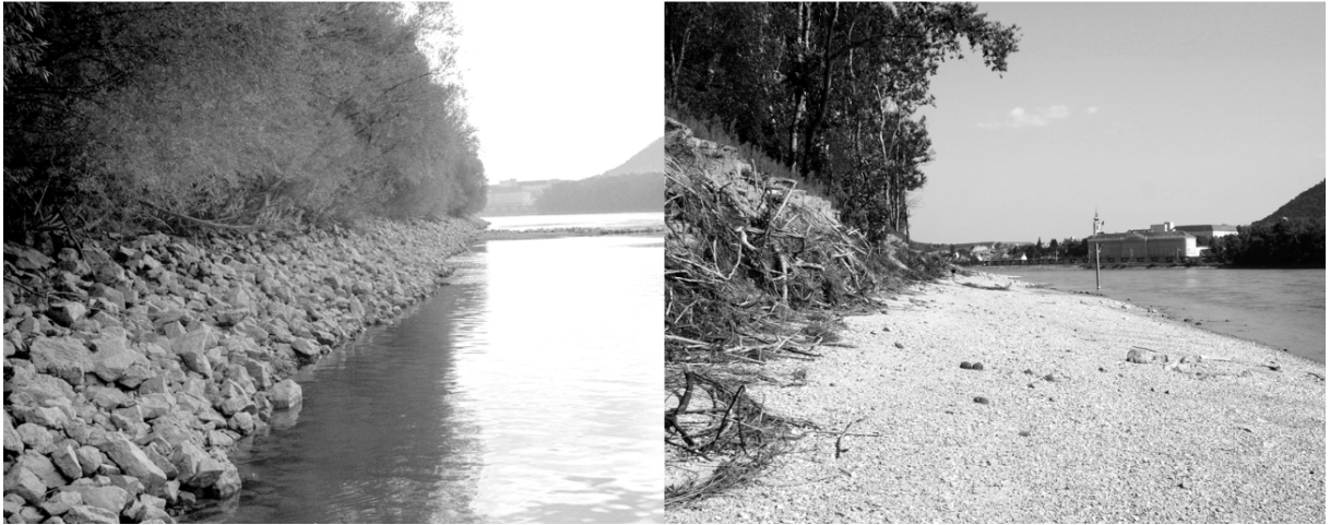
Abb. 34: (links) Ufer bei Strom-km 1885 (knapp stromauf) vor dem Rückbau, der im Winter 2005/2006 erfolgte, und (rechts) nach Rückbau (etwa ein halbes Jahr nach dem Bauende); Quelle: Klasz et al. (2008).
