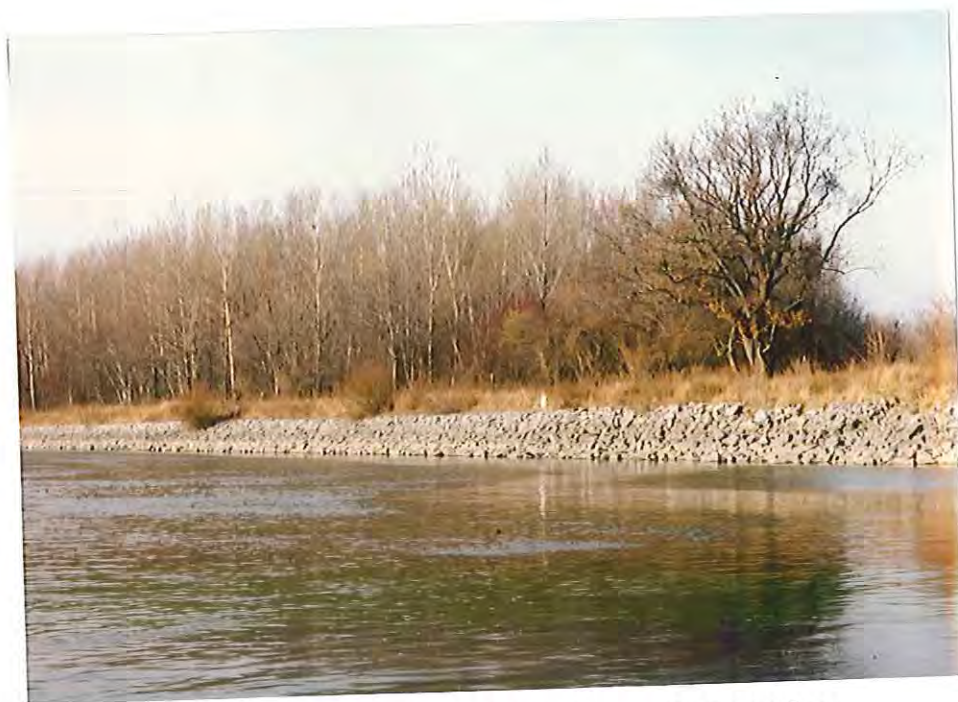
Abb. 37: Blocksteinwurf am Donauufer
