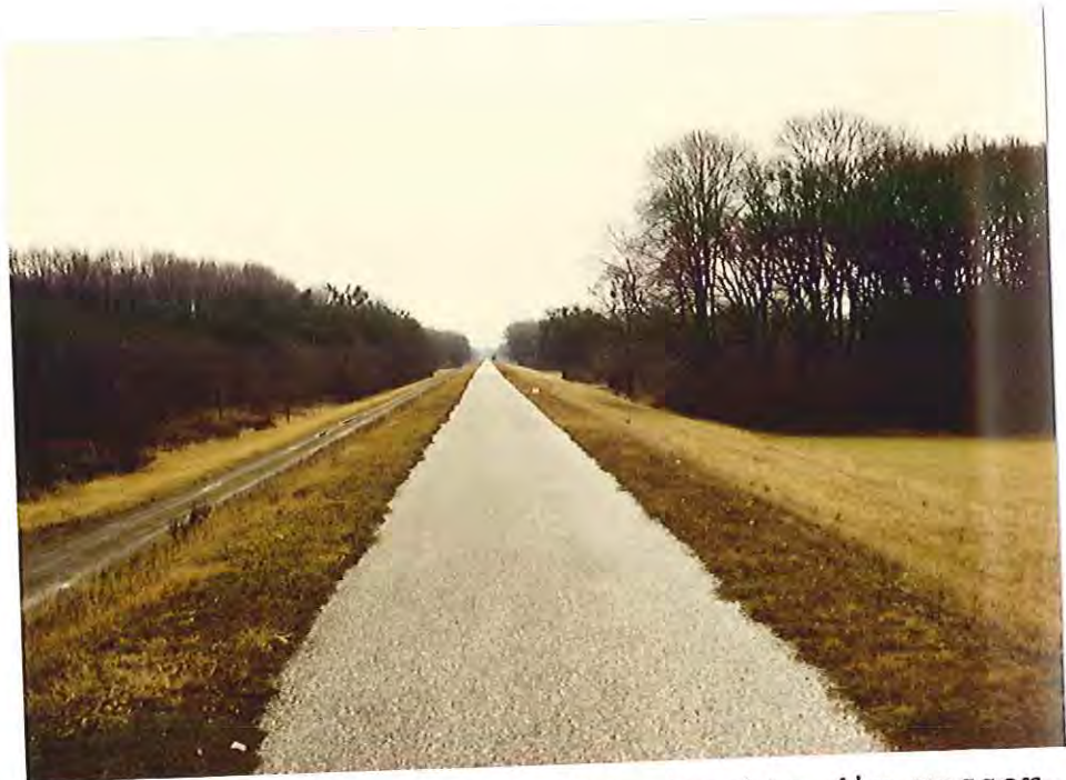
Abb. 43: Marchfeldschutzdamm (rechts die wasserseitige, links die landseitige Berme)
