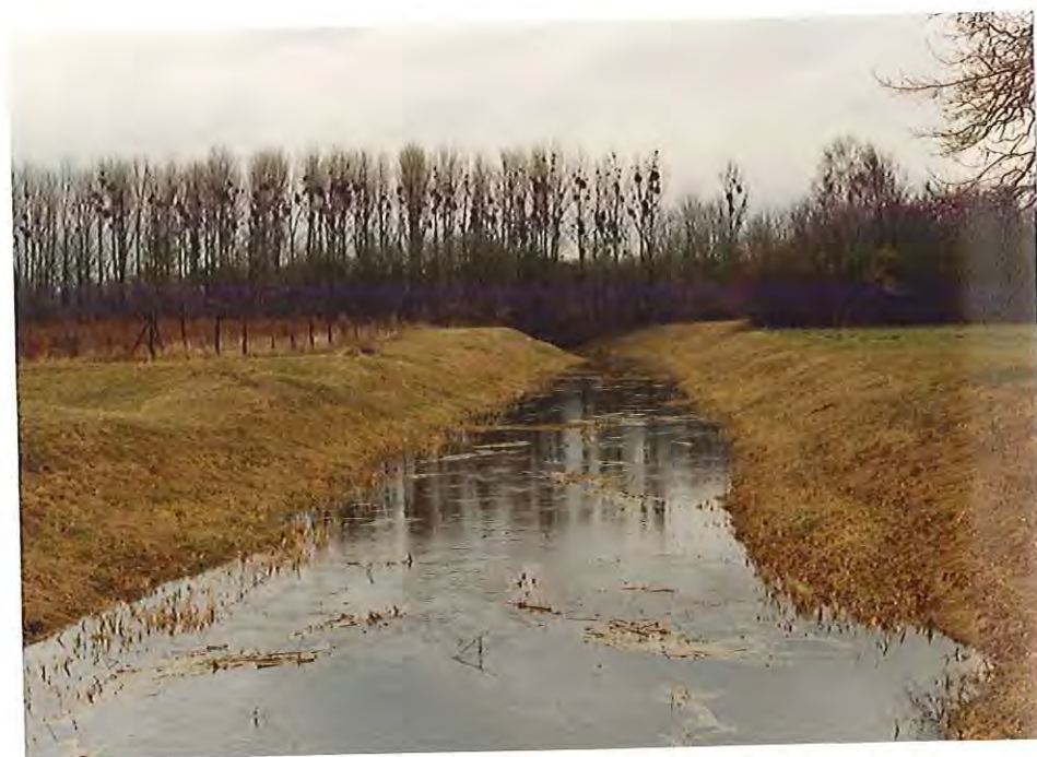
Abb. 10: Grabenstrecke beim März-Hochwasser 1988
